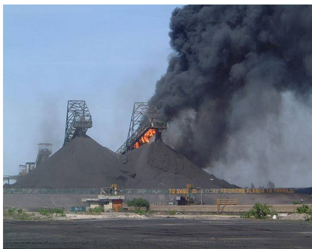
No conveyor belt is fireproof / コンベヤーベルトが難燃性で無い場合
